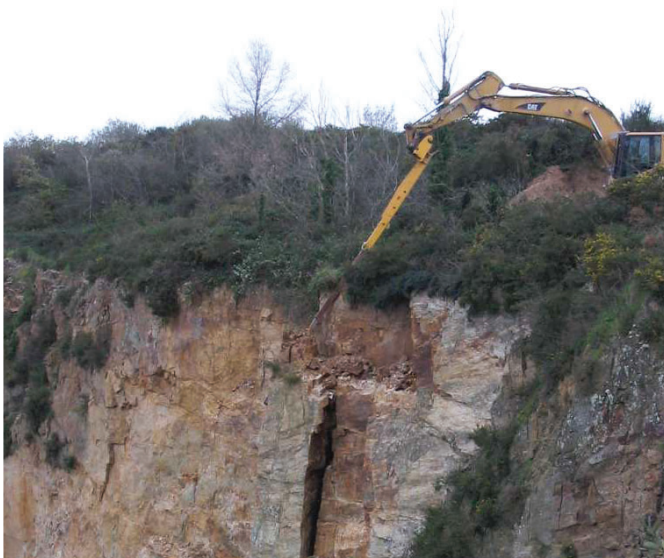
Opération de purge au brise-roche hydraulique sur pelle à chenilles
