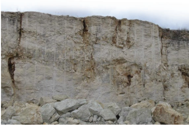
Mise en sécurité par prédécoupage en foration
