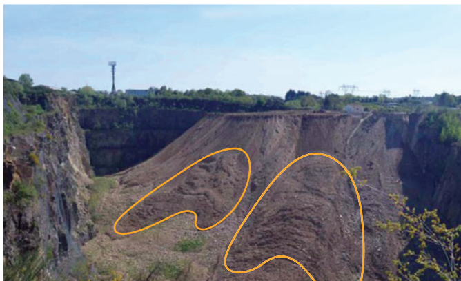
Vue générale d'un talus de verse avec ses lentilles de glissement
