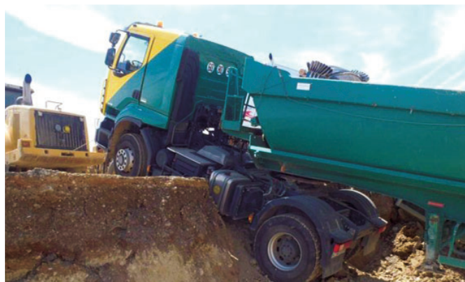
Camion-benne en équilibre instable suite au glissement du talus de verse et de la plateforme
