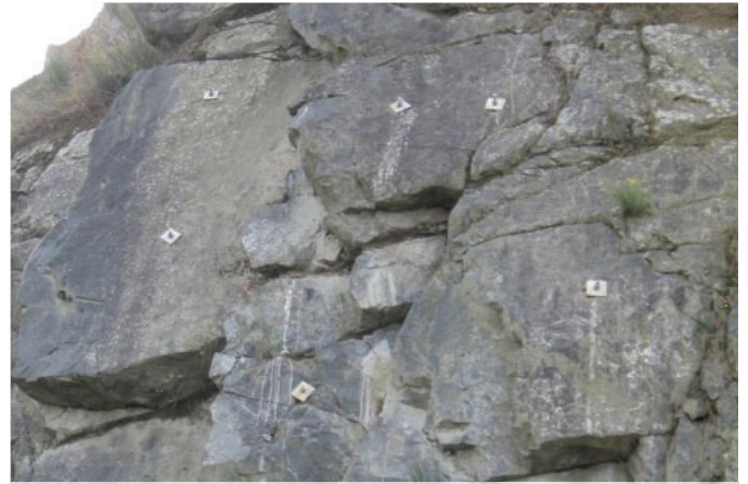
Confortement de front par cloutage avec des tirants
