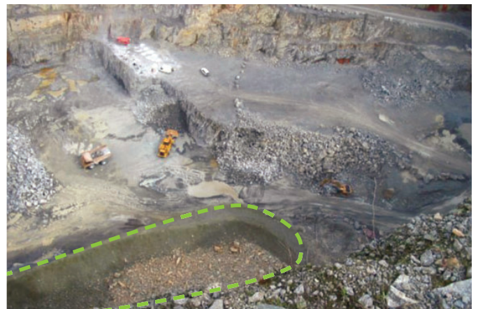
Piège à cailloux sous une écaille instable
